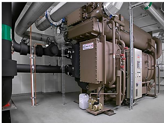
Εικόνες 5 και 6. Η μονάδα των 6 δόμων της AOS εξασφαλίζει μέσω γεννητριών τη παραγωγή ηλεκτρικής και ψυκτικής ενέργειας.
