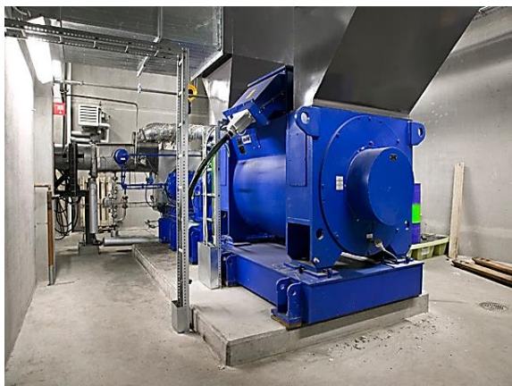
Εικόνες 5 και 6. Η μονάδα των 6 δόμων της AOS εξασφαλίζει μέσω γεννητριών τη παραγωγή ηλεκτρικής και ψυκτικής ενέργειας.
